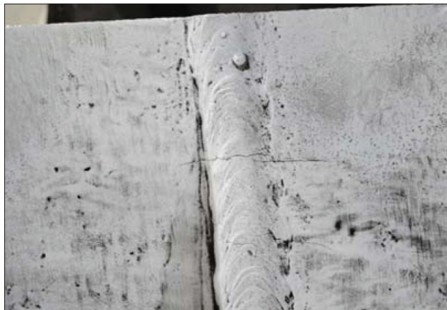
Figura 9 - Test di sensibilità eseguito su Elite BW2 utilizzando un giunto saldato contenente cricche da tenso-corrosione
